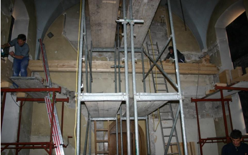
Entstehung der neuen Betempore
